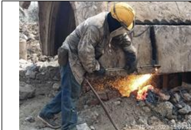
รูปที่ ฐ-43 PPE พื้นฐานที่ทุกคนต้องสวมใส่เมื่ออยู่ในเขตพื้นที่รื้อถอนฯ ได้แก่ หมวกนิรภัย, รองเท้านิรภัย, แว่นตานิรภัยและเสื้อสะท้อนแสง ทั้งนี้จะมี PPE เพิ่มเติมตามอันตรายหน้างานของแต่ละบุคคล
