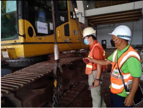
รูปที่ ฐ-51 มีการตรวจสอบอุปกรณ์ เชือก ลวดสลิง และรอก มีขนาดเหมาะสม แข็งแรง ทนทาน และปลอดภัยต่อการใช้งานโดยผู้ควบคุมงาน จป. ก่อนอนุญาตให้ใช้งาน
