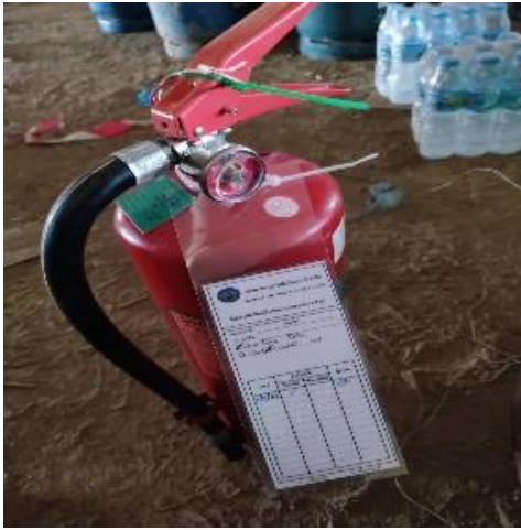
รูปที่ ฐ-49 จป.ดำเนินการตรวจสอบอุปกรณ์ดับเพลิงตามแผนการดำเนินงานด้านความปลอดภัยประจำเดือน
